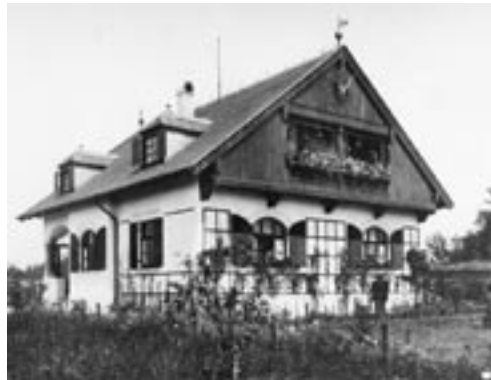
Villa Besold Hauptstraße, erbaut 1902
