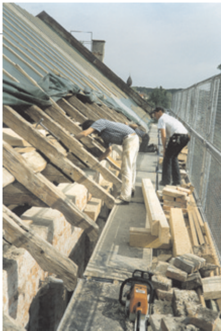
Dachsanierung am Pfarrstadel, 2000
