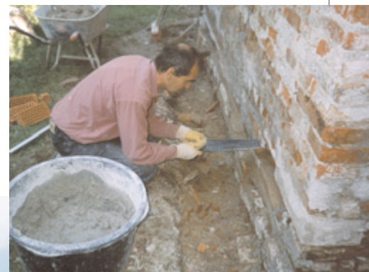
Trockenlegung des Mauerwerks
